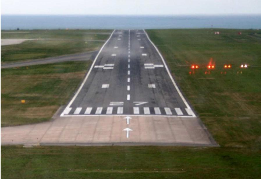
Na pista acima, de número 27, ou seja, com direção magnética de  $270^\circ$ , o PAPI é formado por quatro caixas, contendo dois conjuntos de lâmpadas cada. Duas caixas mostram as luzes vermelhas, uma a cor laranja e a última a cor branca, o que indica estar a aeronave ligeiramente abaixo da rampa ideal. O ideal é que fossem duas caixas vermelhas e duas brancas.
